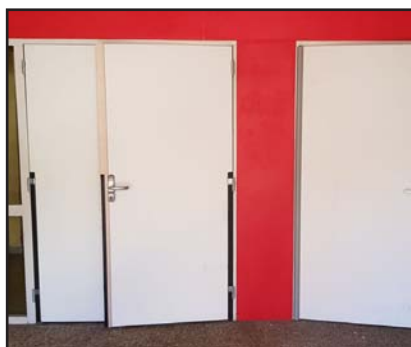
École : portes d'accès sécurisées
