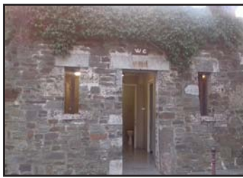
Rénovation des toilettes place du 8 mai 1945
