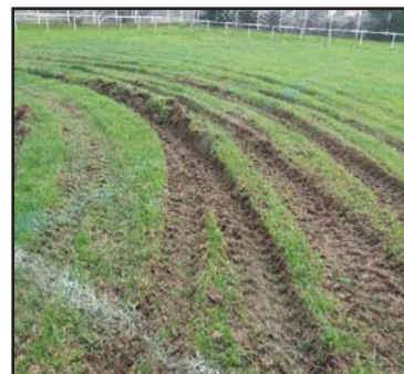
Rénovation pelouse stade
